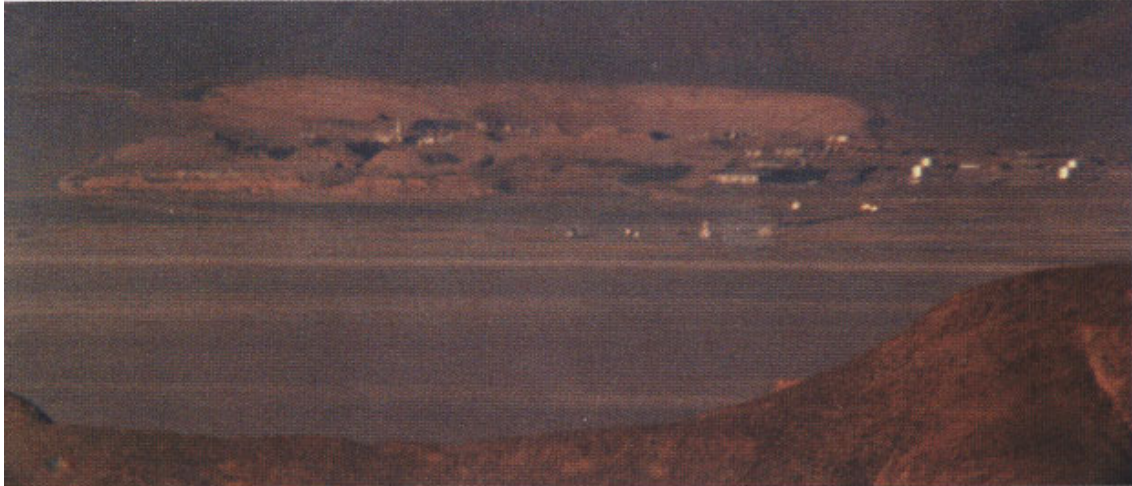
Riesige Erdbewegungen südlich des Zentrums von »51«. Die Anlage wird immer noch vergrößert. Im Vordergrund das Rollfeld, rechts vier Treibstofftanks. (Verfasser)
