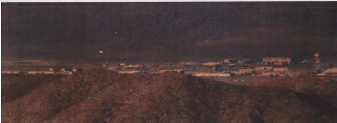
Anlagen direkt nördlich des Haupthangars (H-18). Ganz rechts im Bild einer der Foreign Technology Hangars. (Verfasser)
